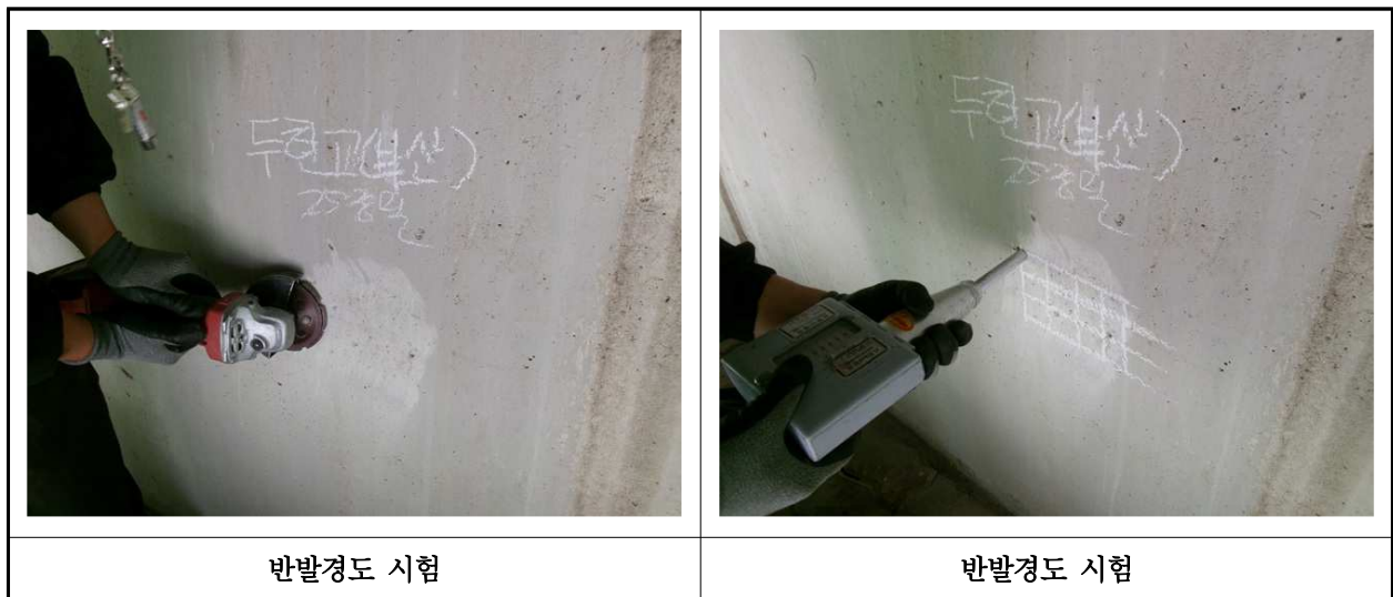
【사진 17.4.2】 반발경도시험 현장사진
