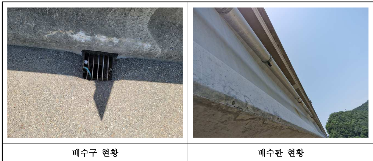
【사진 17.3.22】 배수시설 전경
