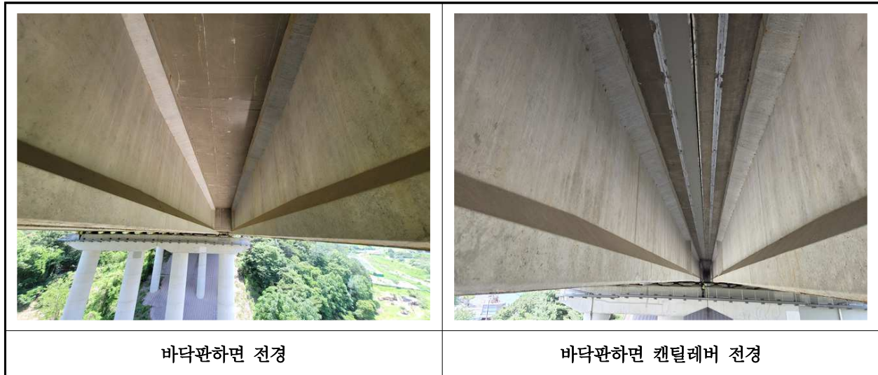
【사진 17.3.2】 바닥판하면 전경
