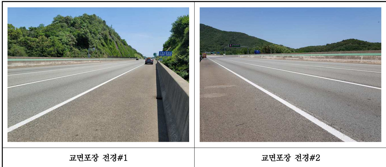
【사진 17.3.20】 교면포장 전경
