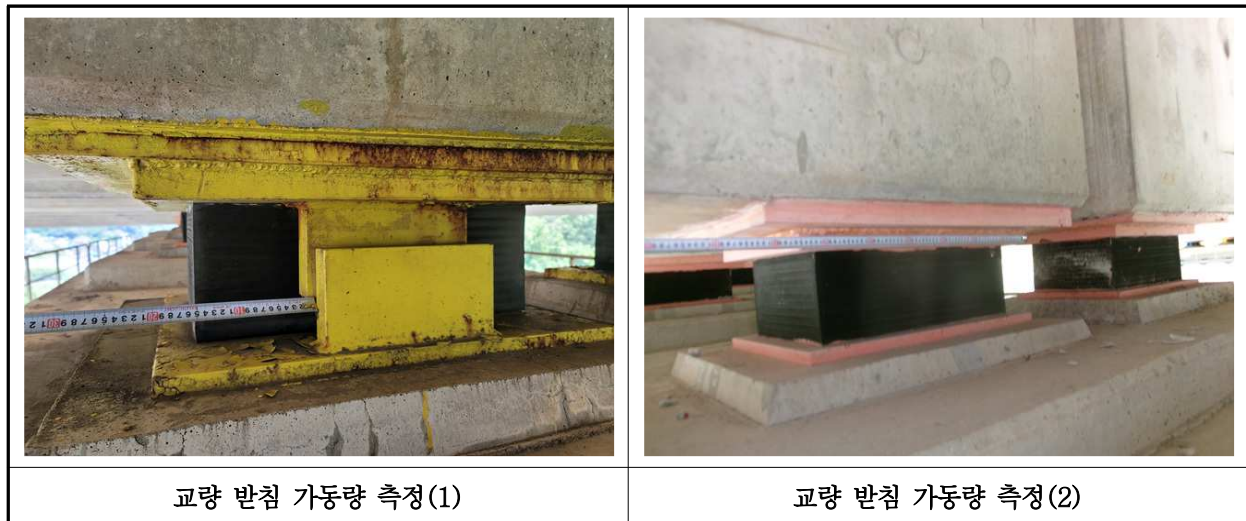
【사진 17.3.16】 교량받침 이동량 측정
