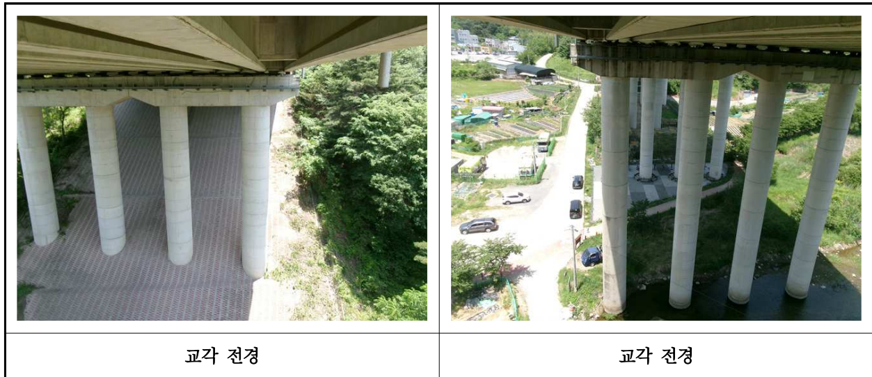
【사진 17.3.10】 교각 전경
