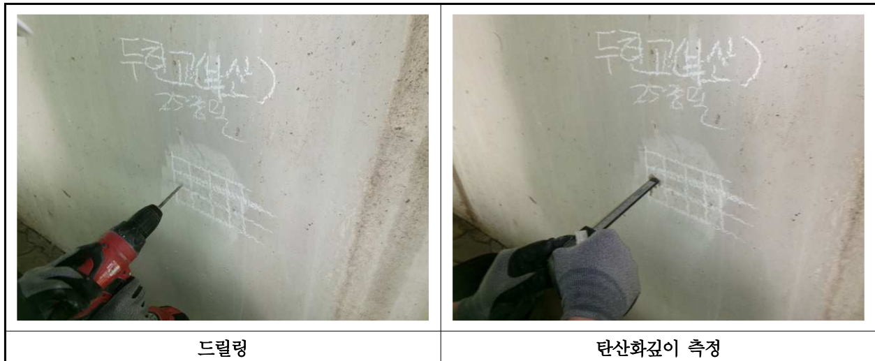
【사진 17.4.3】 탄산화 깊이 측정 현장사진
