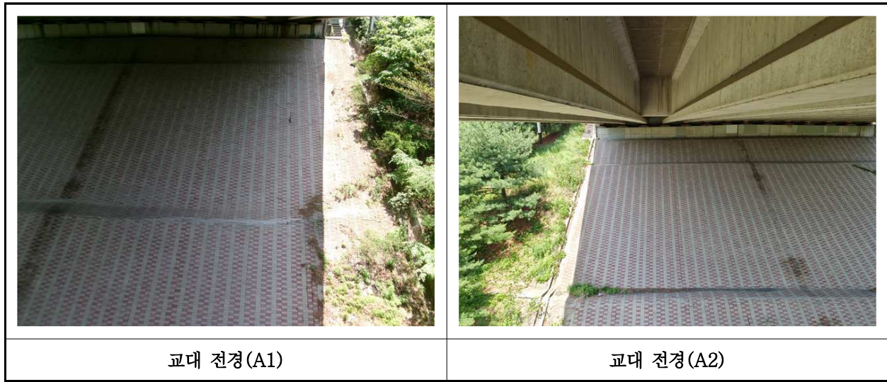
【사진 17.3.8】 교대 전경
