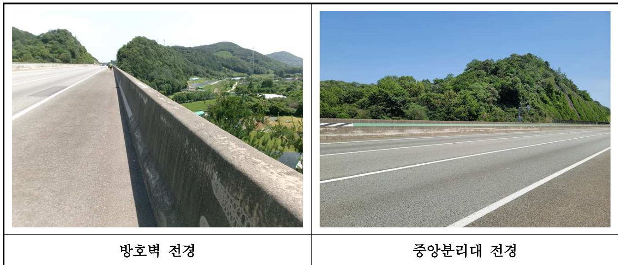
【사진 17.3.24】 방호벽 및 중분대 전경
