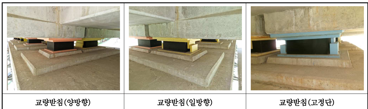
【사진 17.3.13】 교량받침 전경
