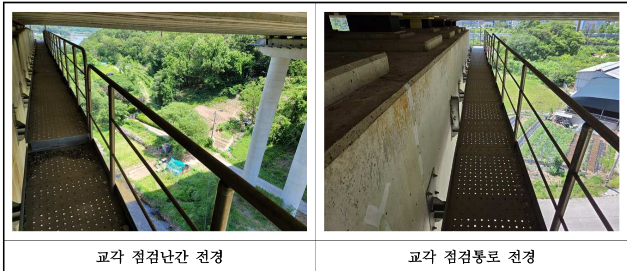
【사진 17.3.26】 교량 점검시설 전경
